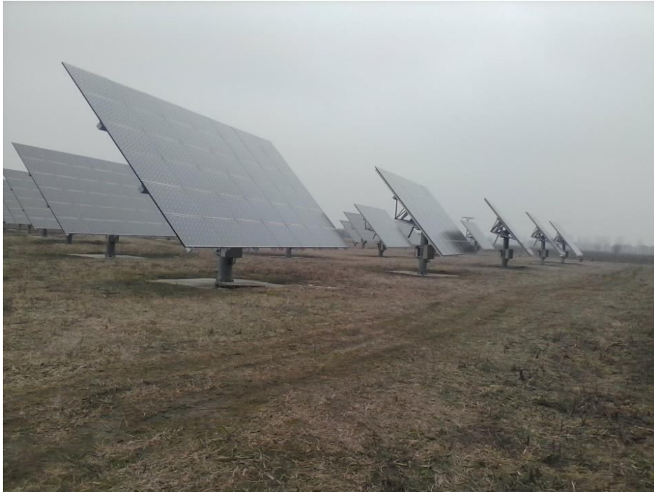
Napkövető üzemben működő Sanyo napelem táblák
